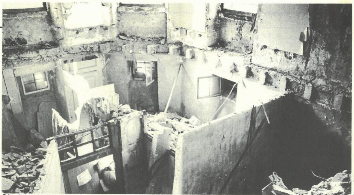
Démolition d'un immeuble locatif à l'avenue du Mail à Genève.
